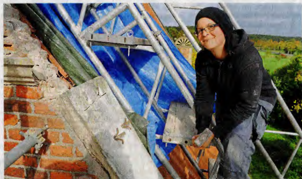
In luftiger Höhe arbeitet Vanessa Maurer von der Firma Monser aus Nordhorn an den Giebelabdeckungen des Hauses Brückhausen.
